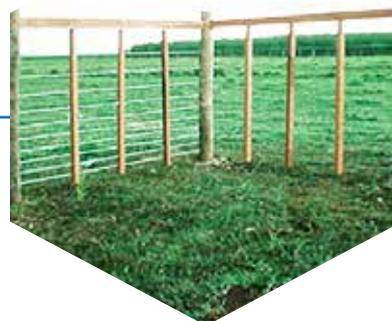
Essa operação deve se repetir em todos os fios da cerca. Ao chegar no último fio, a cordoalha deverá ser fixada com um esticador de parafuso e arrematada da mesma forma que no primeiro.
